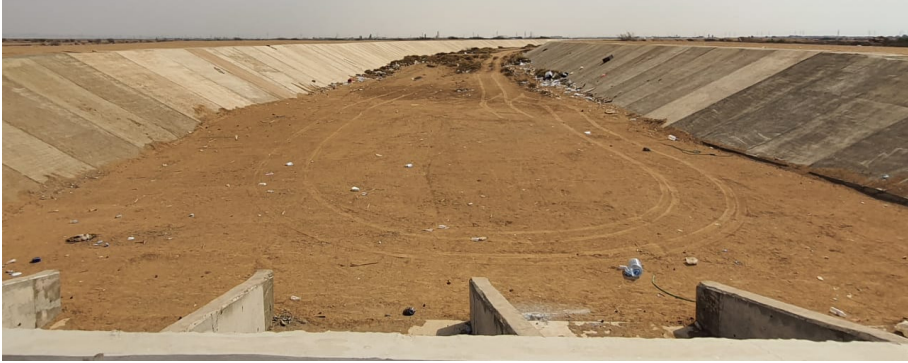
(ب) قطاع من قناة تصريف مياه السيول رقم (٢) قاعها غير مبطن.
