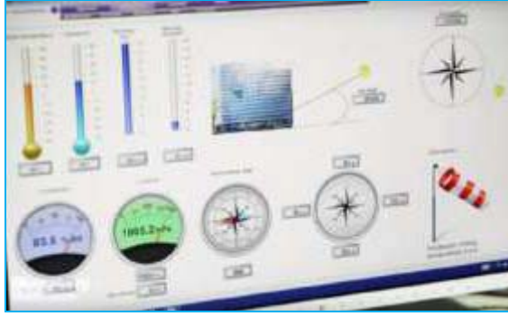
شكل (١١) واجهة التحكم في آبار التبريد والتسخين أسفل المبنى من خلال الحاسب الآلي لوحدة التحكم المركزية بالمبنى [23]
