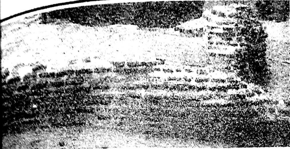
شكل ٦ رصن قوالب الطوب رأسياً بطريقة الفان في الجدار الجبسي المنحرج بحذاء كمر الأحمر كما يظهر عند النظر له من الشمال
