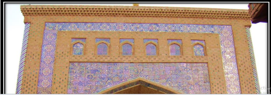
لوحة رقم (٤) شجرة السرو أعلى عقد باب فتحة مدخل مجموعة بهلوان محمود في خيوة، ص ١٩/١٣هـ م
