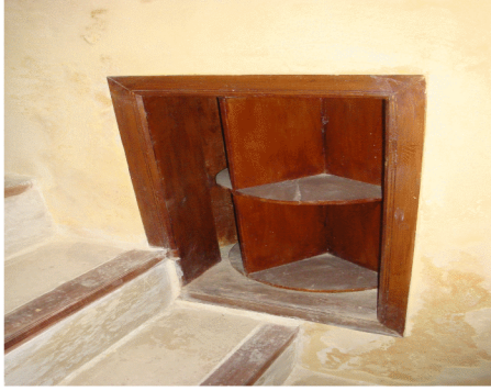
شكل (١٦) خزانة المناولة بمنزل رمضان بعد الترميم
