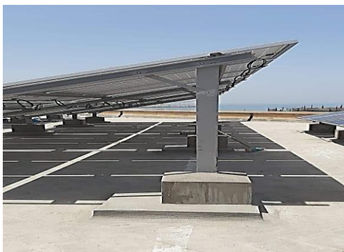
شكل (37) يوضح المسافات البينييه بين الألواح وبعضها وركائز التثبيت: تصوير الباحث لمشروع قائم بمبنى محافظه دمياط: تصوير الباحث
