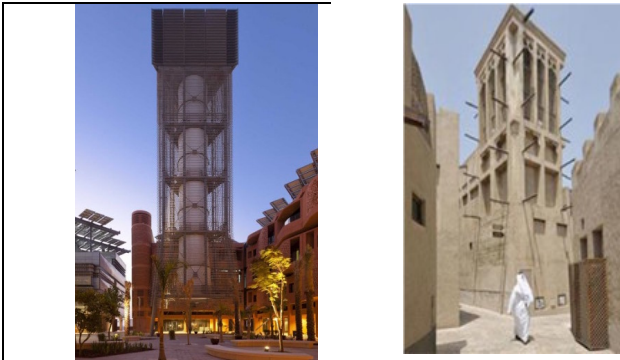
شكل رقم ٢٥ - على اليمين يوضح شكل برج الرياح التقليدي والشكل على اليسار يوضح برج الرياح المستحدث في مدينة مصدر
