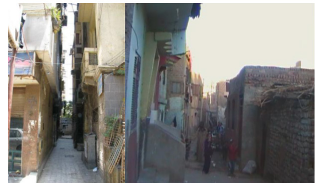
شكل رقم (3) يوضح ضيق الشوارع بين المباني وعدم توفر الخصوصية للمبني في المناطق العشوائية
