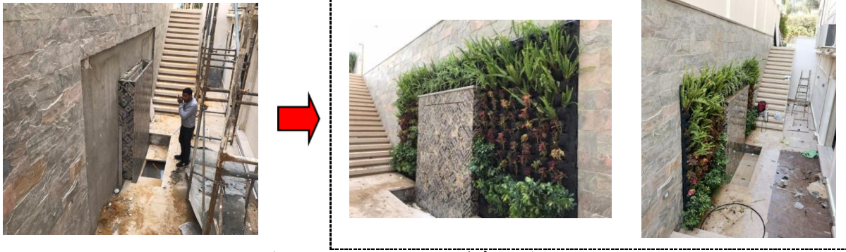
شكل 15: يوضح حائط تم تنفيذه قبل وبعد تركيب الجدار الحي بالنظام المائي. [28]
