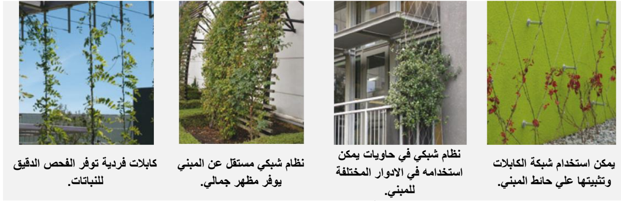
شكل 5: يوضح أشكال هياكل الدعم للواجهات الخضراء. [27]
