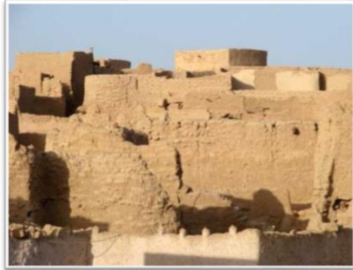
صورة (١٨) - واجهات المباني المكسية بالطين، بمدينة غات الليبية القديمة
