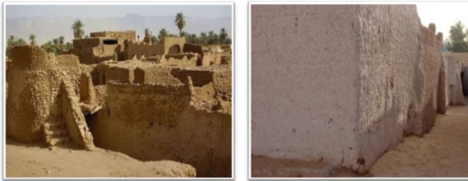
صورة (٢٢)- المساند السميكة التي تدعم بها جدران الأبنية في مدينة غات الليبية القديمة
