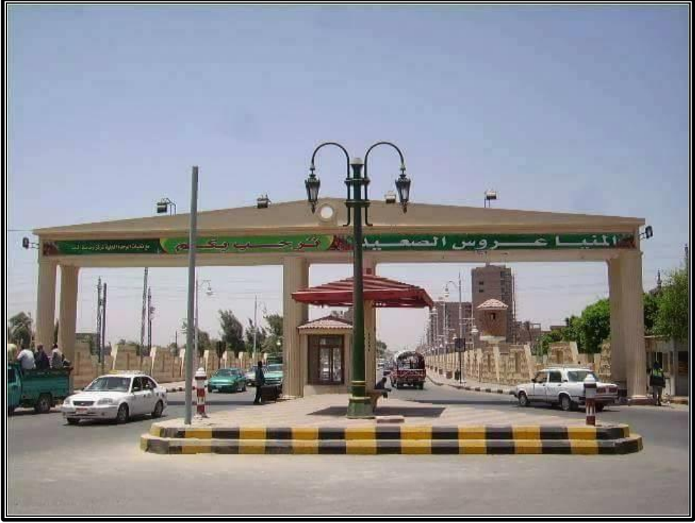
صورة (1) المدخل الشرقي لمدينة المنيا عام 2018م.
