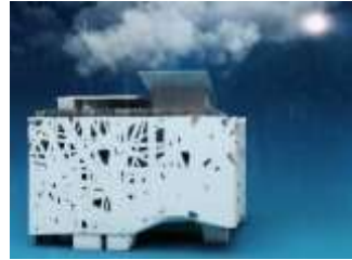
نزول الأمطار مع نعومة سطح الغلاف تجعل من عمليات التنظيف في منتهى السهولة بحيث يتم إزالة الشوائب
