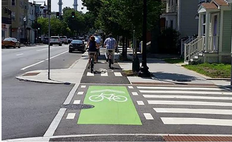
شكل (٦) الممرات المرفوعة وتمييز أرضيتها وإستعمال علامات لفصل نوعي الحركة بينها وبين المشاه المصدر: (Alta, 2014)
