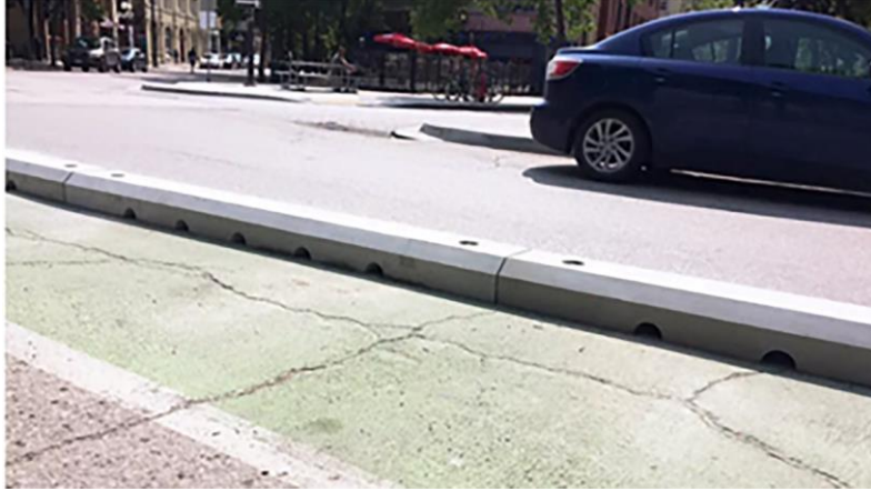
شكل (٤) إحدى أشكال الفواصل الخرسانية والتي تمت معالجتها لتسمح بمرور المياه من خلالها المصدر: (fastcompany.com, 2017)
