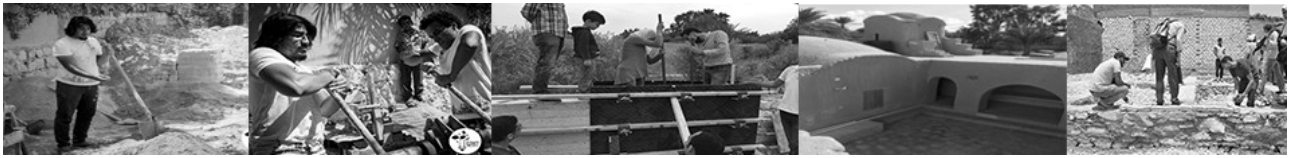
شكل رقم ٣- إشراك الطلاب في بناء مباني صديقة للبيئة باستخدام الطوب الطيني المضغوط بمدينة الفيوم (المصدر المعماري عادل فهمي)
