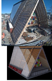
شكل رقم ٩. يوضح المشروع أثناء تنفيذ الهيكل الإنشائي، المصدر: Christchurch's Transitional Cathedral is set to become an icon of the city's post-earthquake rebuild – a symbol of hope for the city and region pdf
