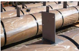
شكل رقم ٨ - يوضح طريقة ربط الهيكل مع المواد المستخدمة الهيكل الإنشائي والورق المقوي المستخدم في تكوين الهيكل الإنشائي، المصدر: Christchurch's Transitional Cathedral is set to become an icon of the city's post-earthquake rebuild - a symbol of hope for the city and region pdf
