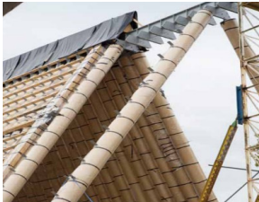
شكل رقم ٨ - يوضح طريقة ربط الهيكل مع المواد المستخدمة الهيكل الإنشائي والورق المقوي المستخدم في تكوين الهيكل الإنشائي، المصدر: Christchurch's Transitional Cathedral is set to become an icon of the city's post-earthquake rebuild - a symbol of hope for the city and region pdf
