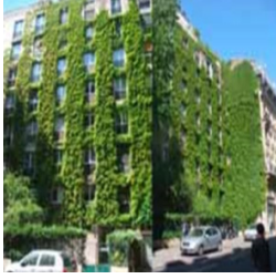
شكل رقم ١ - يوضح أحد أنظمة النباتات المتسلقة مباشرة على الواجهة، المصدر: www.greenscreen.com2015
