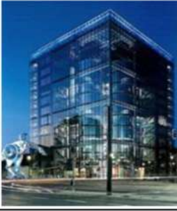
شكل (١٢) الواجهة الرئيسية لمبنى أكاديمية وسائط الطباعة 18 .
