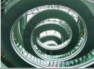
شكل (٢٨) الممر الداخلي الحلزوني داخل المبنى ٤٣ .
