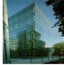
شكل (٣٥) الواجهة الخارجية لمبنى فيكتوريا بألمانيا ٤٨ .
