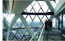
شكل (٢٢) الأغلفة المزدوجة لبرج Swiss Re Tower
