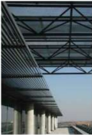
شكل (٢٤) الخلايا الفوتوفولتية بالسقف لتوليد الطاقة الكهربائية بمبنى شركة كهرباء مدريد
