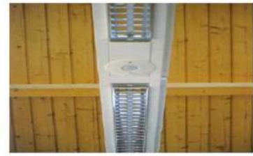
شكل (١٨) أجهزة استشعار الإضاءة بالسقف ٣٢ .
