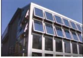
شكل (٤) كاسرات شمسية زجاجية متحركة طبقاً لكمية الضوء المطلوبة لتحقيق الراحة بالفراغ ١١ .
