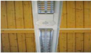
شكل (٣٢) حساسات الإضاءة بالسقف ٤٦
