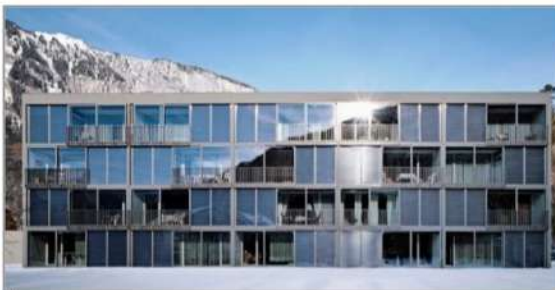
شكل (١٧) واجهة مبني " Sur Falveng " حيث تظهر تغطية الواجهه بالزجاج متغير الطور {١١} .
