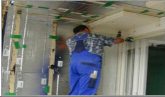
شكل (٩) الواح (VIP) بحوائط و سقف المبني {٣٣}.
