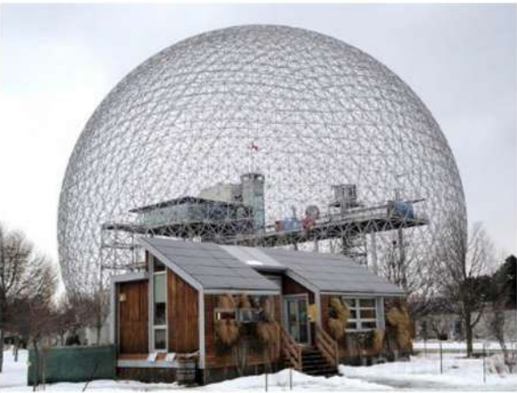
شكل ٦ استخدام التنظيم الشبكي في القبة الجيوديسية لبكمنستر فولر (Buckminster Fuller)، والمصدر: http://inhabitat.com
