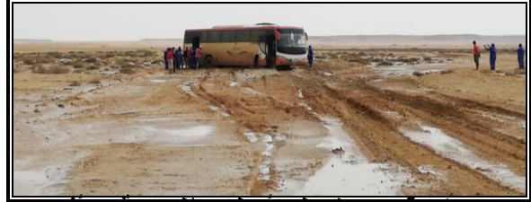
(صورة رقم ٦) سقوط الأمطار الفجائية وتأثيرها على طريق البترول وانجراف التربة بمناطق متفرقة من منطقة الدراسة باتجاه تصوير جنوب غرب
