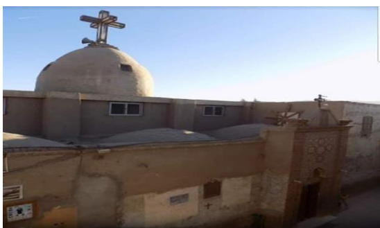
Fig. 7: L'entrée principale du " Monastère du Pape Athanase Al-Zawya". de ( https://www.wataninet.com/2020/05 ) (accès en 17-2-2021)
