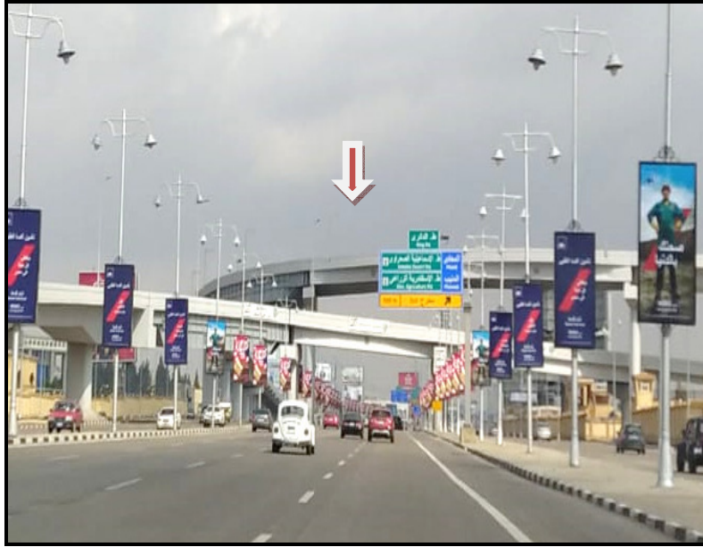
صورة (٦) : تقاطع كوبرى جاردينيا ٤، ٥ على طريق القاهرة السويس.
