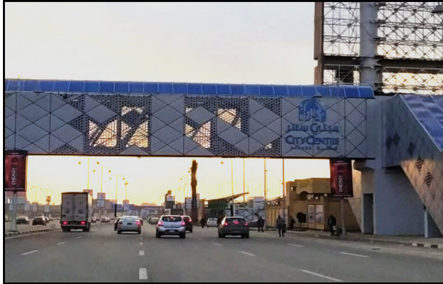
صورة (٢٤) : كوبرى المشاه والسلم الكهربائي الخاص بسيتى سنتر ألاماظة.
