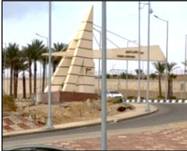
صورة (٨) : مخرج ومدخل مطار القاهرة على طريق القاهرة السويس الصحراوى.
