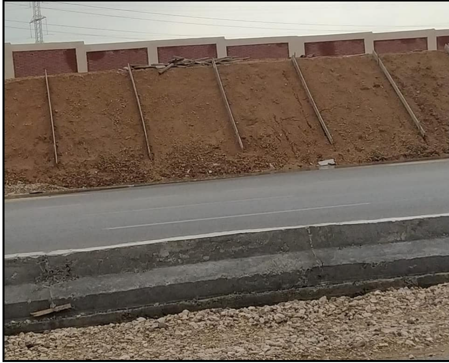
صورة (٢٧): أعمال التكسية للتكوينات الصخرية والرملية للطريق عند منطقة المقابر.
