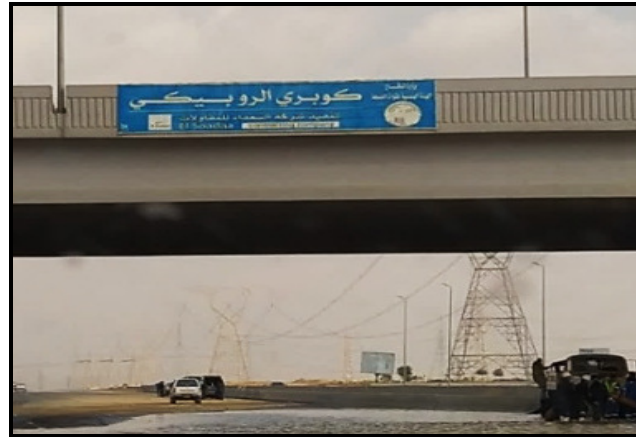
صورة (١٥): كوبري الروبيكي على طريق القاهرة السويس.
