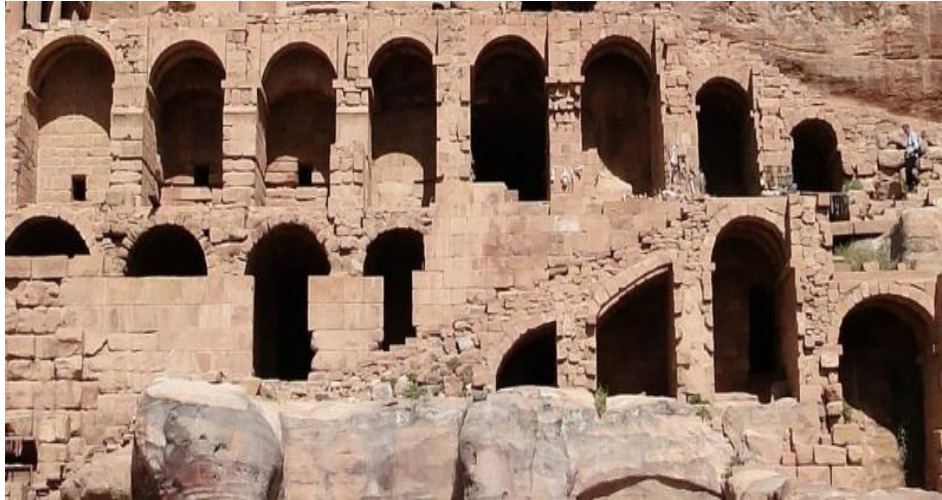
صورة(١) توضح نموذج لبناء السقف على نظام العقود في مبنى المحكمة في مدينة البتراء
