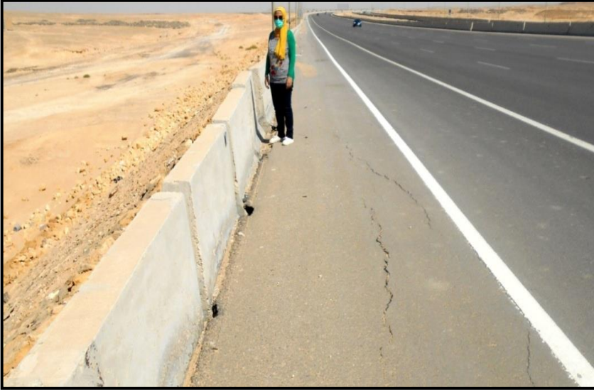
صورة (٥) بعض التشققات في طريق القطامية- العين السخنة، وقد تكونت أعلى برباخ السيول لوادي القطامية أحد روافد وادي الجفرا، تصوير ٤ يونيو ٢٠٢٠ (ناظرًا صوب الغرب)
