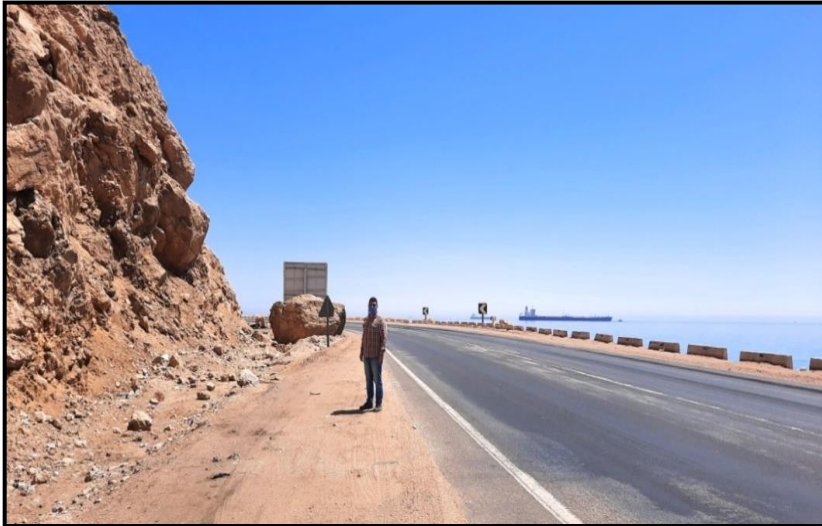
صورة (١٢) أحد المنعطفات الأفقية بطريق العين السخنة - الزعفرانة، وتمثل واحدة من النقاط العمياء في الطريق، بالقرب من ملف الماسورة (ناظرًا صوب الشمال)
