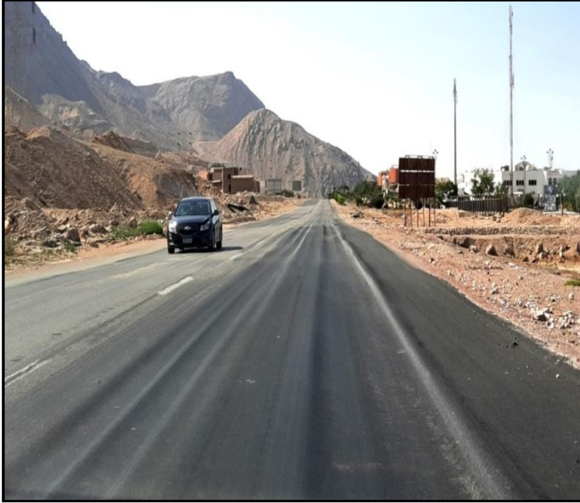
صورة (٣) تموجات في الطبقة الأسفلتية في أحد أجزاء قطاع العين السخنة - الزعفرانة (ناظرًا صوب الشمال الغربي)
