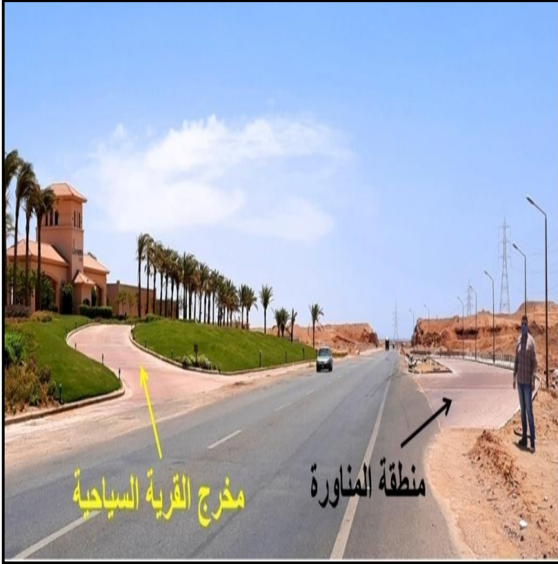
صورة (٩) مخرج قرية لافيستا ٦ ومنطقة المناورة أمامه، ويلاحظ أن المخرج شديد الانحدار، ويتصل بالطريق بزاوية شبه عمودية (ناظرًا صوب الجنوب الشرقي)
