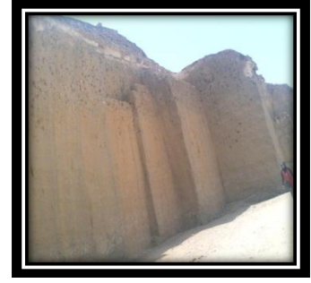
صورة (٥٥) التحجير خارج أحد جدران معبد ارتيميتس ببني حسن، يظهر بأعلى الجدارحفر الإذابة .
