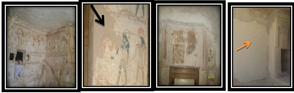
صورة (٢٢) تقشر الطبقة الخارجية للجدار الشمالي لأحد مقابر الزاوية . صورة (٢٣) التقشر بأحد سراديب تونا الجبل. صورة (٢٤) التقشر بأحد جدران مقبرة بيتوزيرس بتونا الجبل. صورة (٢٥) التقشر بجدران وأسقف كنيسة يوحنا المعمدان.
