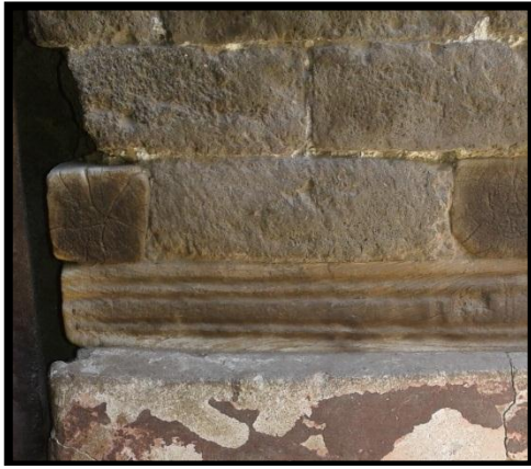
صورة (٢) تعرض الألواح الخشبية للتعفن بفعل الرطوبة بأحد جدران البوابة القبلىة لمسجد العسقلانى بملوى.
