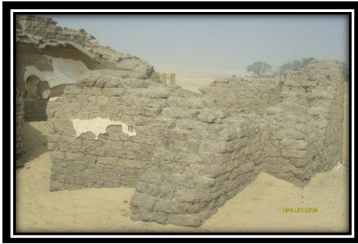
صورة (٦) مادة بناء المقابر الرومانية بتونا الجبيل ( الطوب اللبن المغطي بطبقة من الجص ) .
