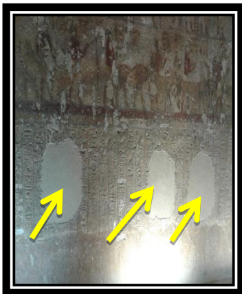
صورة (٦٧) الحائط الشرقى لمقبرة خنوم حتب ببنى حسن، حيث استخدام الأسمنت فى عمليات الترميم مما أدى إلى تشويه النقوشات وتساقط بعضها .
