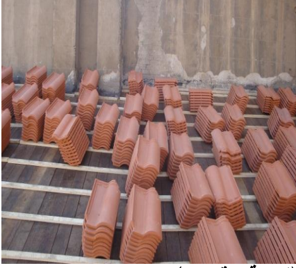
(لوحة رقم ١٩) القرميد الذي يوضع فوق العلفات الخشبية بسطح الكنيسة
