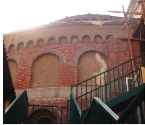
(لوحة رقم ١٢) الجهة الشرقية من الخارج ويظهر بها الكورو الذي يحيط بمنصة الشمامسة ونصف القبة التي تغطي حضان الآب
