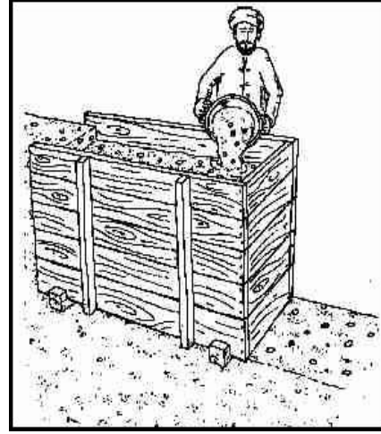
شكل (٥): يوضح سكب خليط الطابية في الصندوق. عن: M. Teresa y otras: La Alcazaba , p.9.
