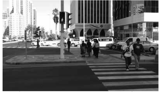
شكل (9) يوضح أحد معابر المشاة السطحية والمزود بإشارات ضوئية بمدينة أبو ظبي [3]
