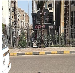
شكل (19) صورة توضح السور الحديدى بالجزيرة الوسطى لمنع عبور المشاة السطحي والذي تم عمل فتحات به لعبور المشاة المصدر الباحث
