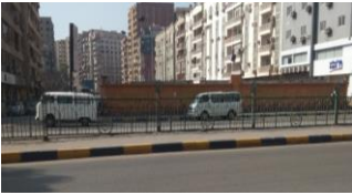
شكل (28) صورة توضح السور الحديد لمنع عبور المشاة السطحي والذي تم عمل فتحات به لعبور المشاة - المصدر الباحث
