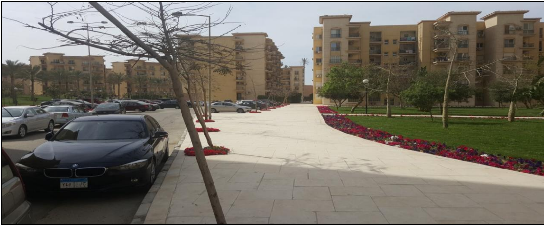
شكل رقم (19) عروض الأرصفة مناسبة لحركة المشاة وتزيد عند تلامسها مع الحركة الآلية للحماية للمستخدمين
