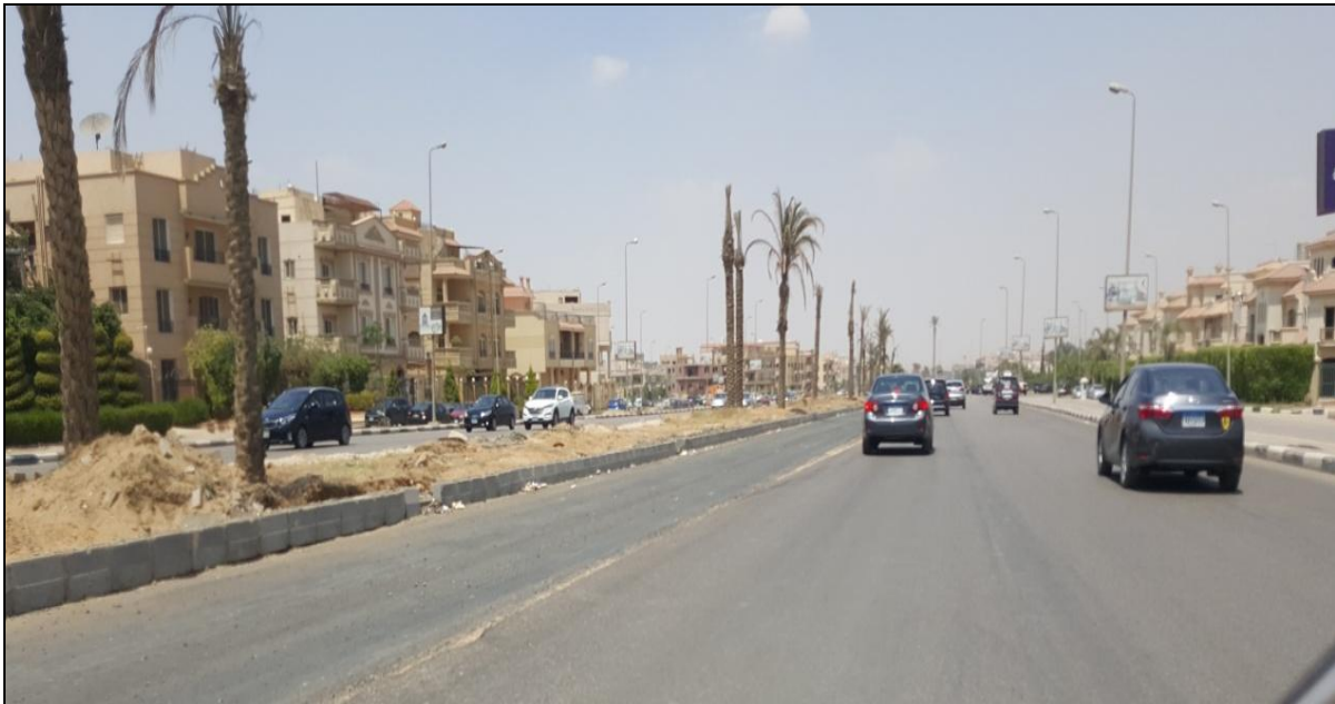
شكل رقم (15): زيادة عرض الطريق التسعيني لحارة السيارات في كل اتجاه على حساب الجزيرة الوسطي أعمال التطوير الحالي (أبريل 2018)
