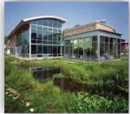
شكل 2 يوضح مبنى الاتصال والهاتف (2)
