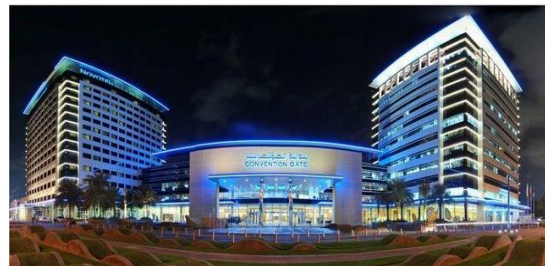
شكل (41) المدخل البارز للخارج (مركز دبي التجاري)
