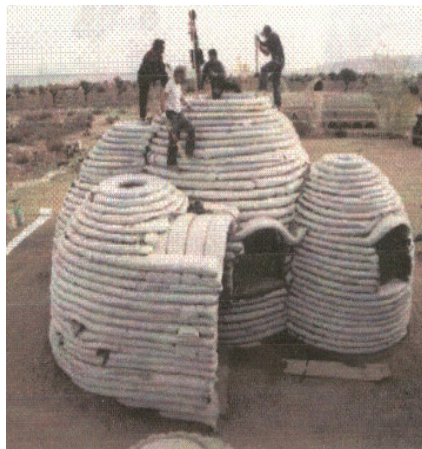
شكل رقم ٢٧- مثال للبناء بمادة الرمل الناعم
