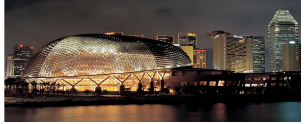
شكل رقم ٣٩- الأصداف المقوسمة مركبة بطريقة الكترونية بحيث تتعامل مع زوايا الشمس العالية المحرق ١٢
