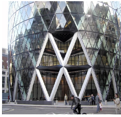
شكل رقم ٣٤- برج سويس ري Tower The Swiss Re ذو غلافاً ذكياً متفاعلاً مع البيئة ١
