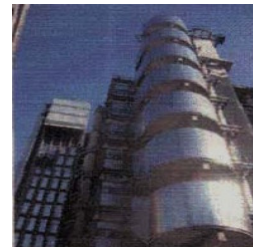
شكل رقم ١٤ مبنى لويد جونز في لندن مغلف بالكامل بمادة الاستنسل
