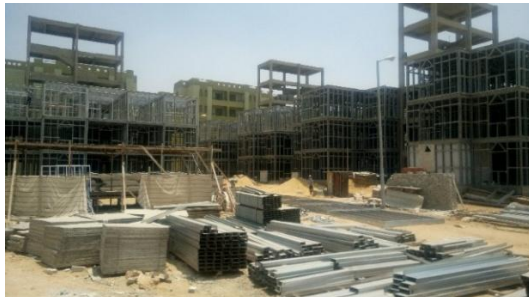
شكل رقم (7) تشكيل وتجميع البانوهات بموقع المشروع
