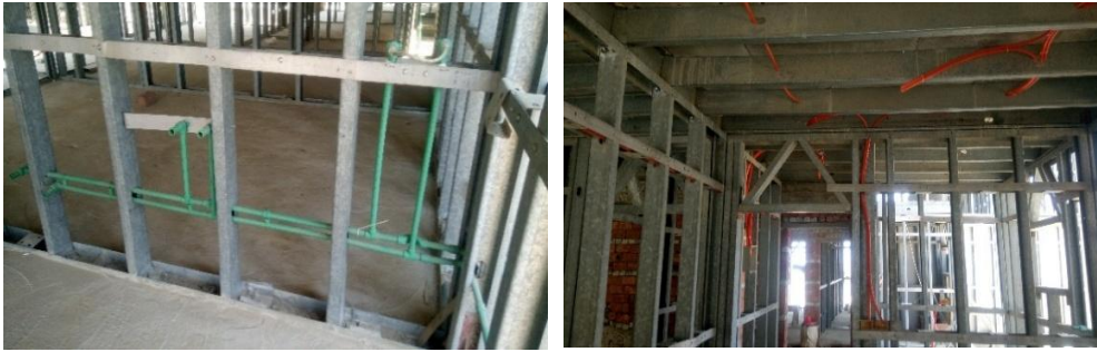
شكل رقم (9) تنفيذ أعمال التمديدات الصحية والكهربائية
