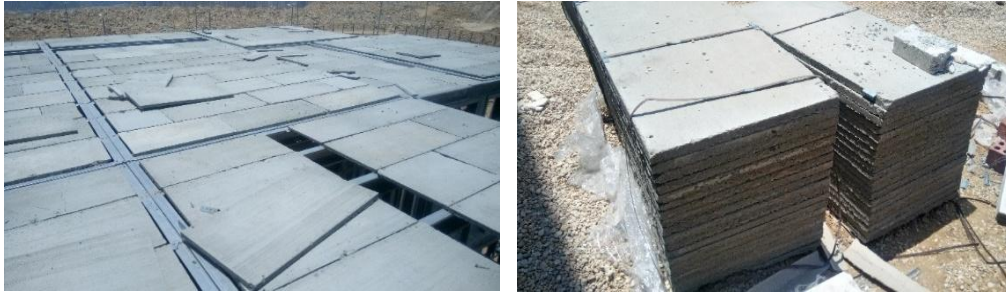
استخدام ألواح الفيروسيمينت لتغطية الأسطح
