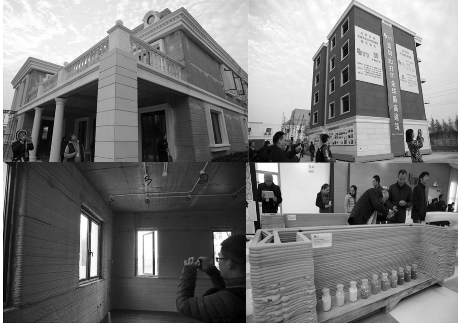
شكل (7) - تجربة الصين في استخدام تقنية التشييد الرقمي الكنتوري في إنتاج المباني. المصدر: موقع شركة www.winsun.com الصينية بتاريخ 07-02-2018.
