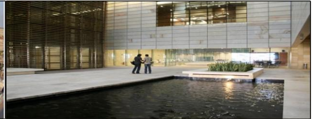
شكل (11) برك المياة خارج المبنى 22
