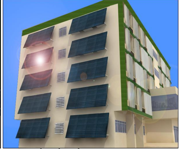
شكل(40) تركيب خلايا شمسية بالواجهة الجنوبية
