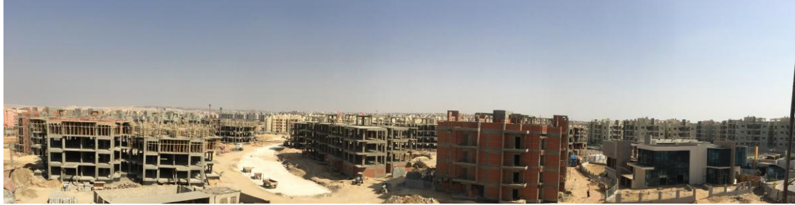
شكل يوضح المراحل المتعددة وإنجاز الاعمال بالمشروع بعد عشرة أشهر
