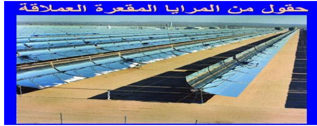
شكل (9) يوضح مرزعة شمسية من المرايا المجمعّة وتركيز اشعة الشمس لإنتاج طاقة نظيفة من الكهرباء
