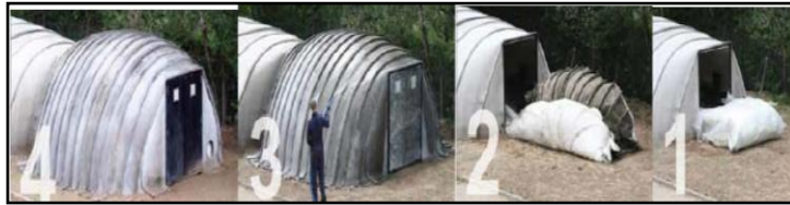
شكل (4) أربعة خطوات لتجهيز ملجئ إسمنتي من الأقمشة الإسمنتية
