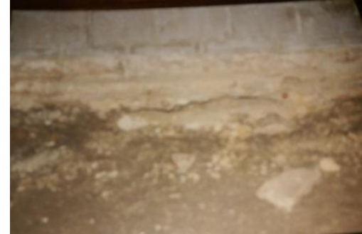
الصور رقم (3) الطبقات أسفل ارضية المسجد
