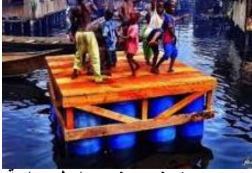
صور توضح وضع براميل هوائية لرفع المبنى ليطفو
