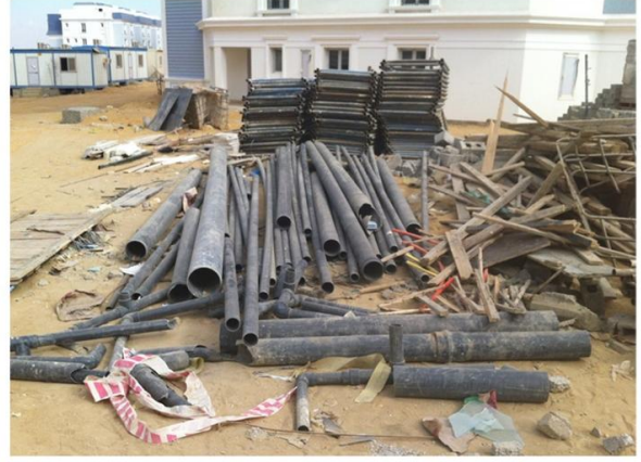
شكل 4. تلف مواد البناء نتيجة سوء التشوين
