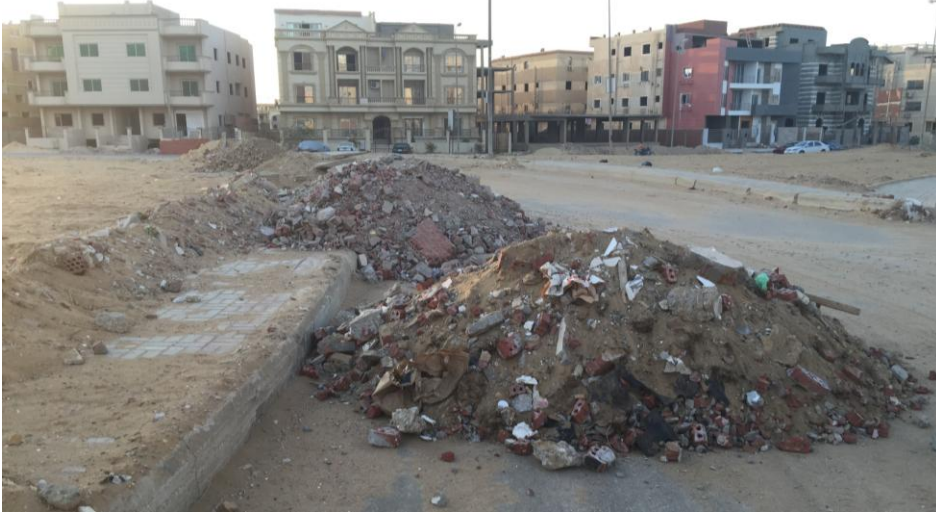
شكل 15. التخلص من مخلفات البناء في الطرق العامة
