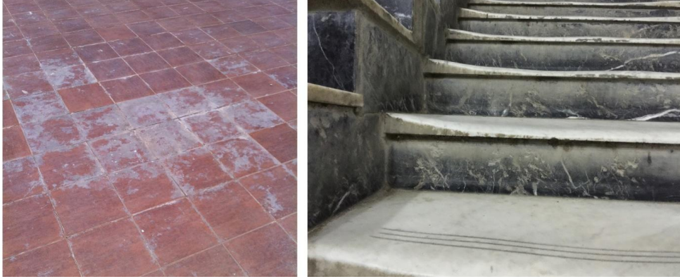
شكل 10. اختيار مواد بناء لا تتناسب مع الوظيفة
