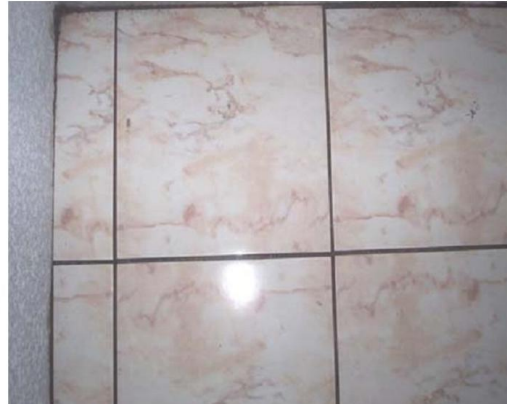
شكل 11. اختيار سيراميك لا تتناسب أبعاده مع أبعاد الفراغ
