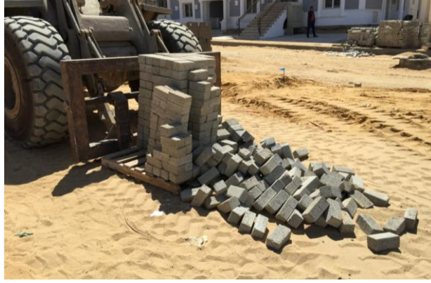
شكل 9. نقل مواد البناء داخل الموقع
