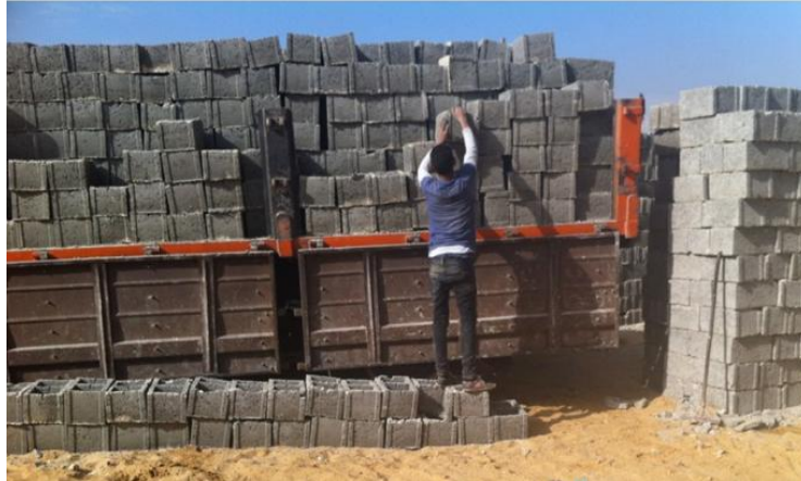
شكل 2. عمليات التفريغ لمواد البناء والهالك الناتج عنها
