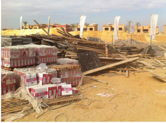
شكل 4. تلف مواد البناء نتيجة سوء التشوين
