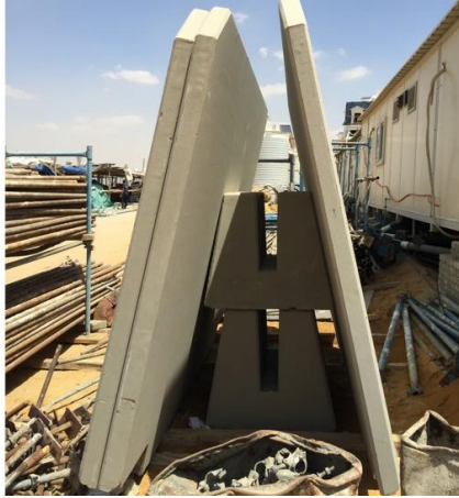
شكل 13. الأسوار المؤقتة داخل المشروع للفصل بين مراحل المشروع
