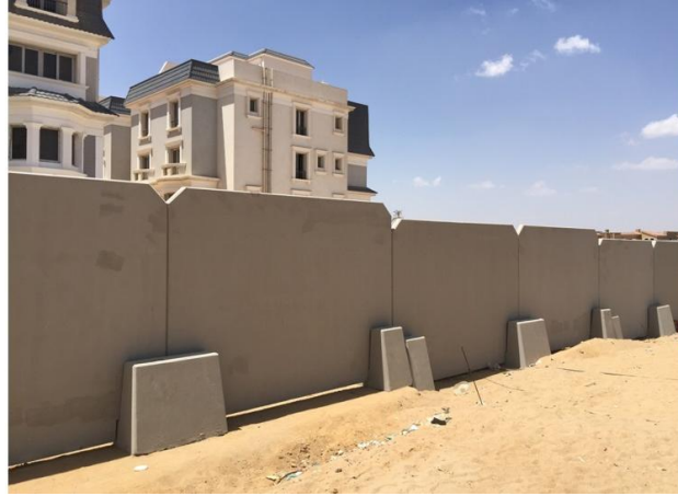
شكل 13. الأسوار المؤقتة داخل المشروع للفصل بين مراحل المشروع
