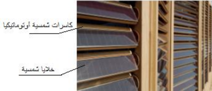
شكل (11): منزل ديكاتلون الذي استخدم التظليل الشمسي من إطارات الخشب مع الخلايا الضوئية في واجهة المبنى 2007
