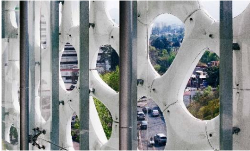
شكل 12 يوضح شكل الواجهة الرئيسية للمستشفى شكل 13 يوضح شكل البلاطات Prosolve 370e المثبتة علي واجهة المستشفى من الداخل والبلاطات المثبتة عليها
