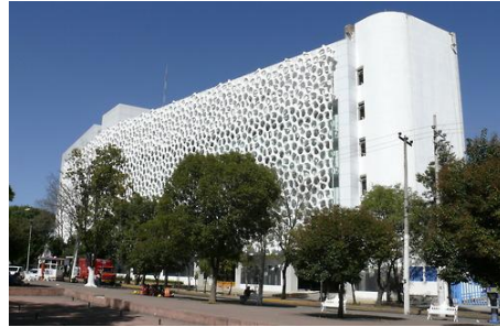
شكل 12 يوضح شكل الواجهة الرئيسية للمستشفى شكل 13 يوضح شكل البلاطات Prosolve 370e المثبتة علي واجهة المستشفى من الداخل والبلاطات المثبتة عليها
