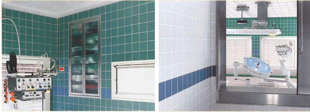
شكل 11 يوضح معالجة غرفة العمليات بحوائط من السراميك مضادة للبكتريا
