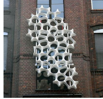
شكل 8 يوضح استخدام نوع من البلاطات خفيفة الوزن على الواجهات لتنقية الهواء الخارجي [9]
