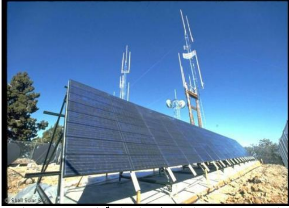
شكل [2]: يوضح تشغيل المحطات اللاسلكية البعيدة باستخدام الخلايا الفوتوفولتية [4].
