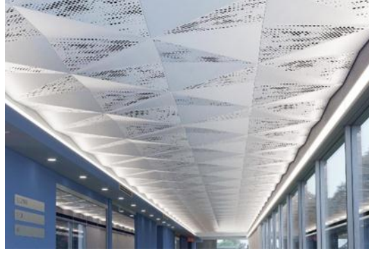
صورة (٤٨) استخدام أسقف ألميوت في الممرات الطويلة
