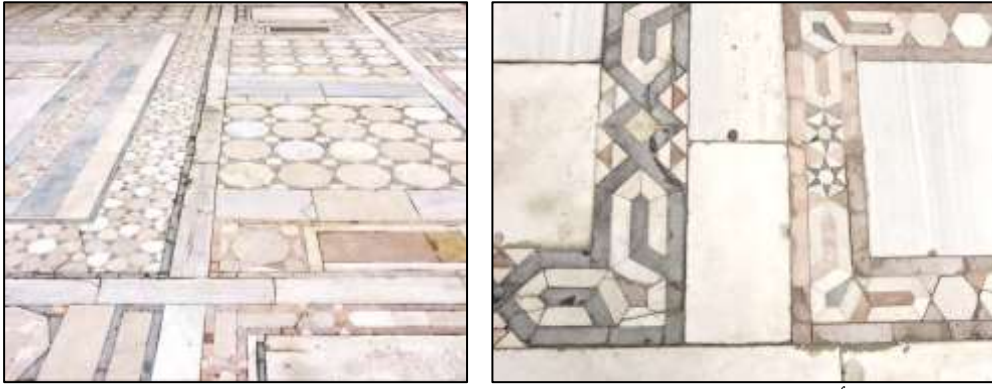
شكل (8): تطعيمات في الأرضيات منفذه بالرخام بتقنية Opus Sectile مسجد السلطان حسن بالقاهرة - القرن 15م دولة المماليك https://cutt.us/Wktr, 5/5/2017
