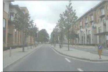
المباني المستمرة على طول الشارع، وقرب الطريق من المباني
