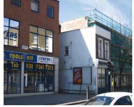
شكل (١٣) تراجع خط البناء لبعض المباني يمكن ان يتسبب في مناطق غير مرئية وظهور واجهات جانبية خالية من المظهر الجمالي [31]
