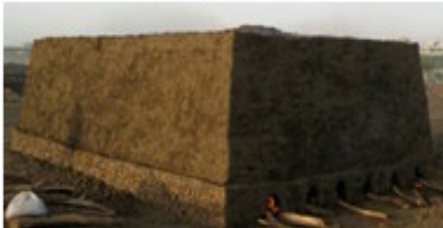
شكل رقم ٧- الأسلوب التراثي لحرق الطوب، المصدر : ( http://www.brickdirectory.co.uk )
