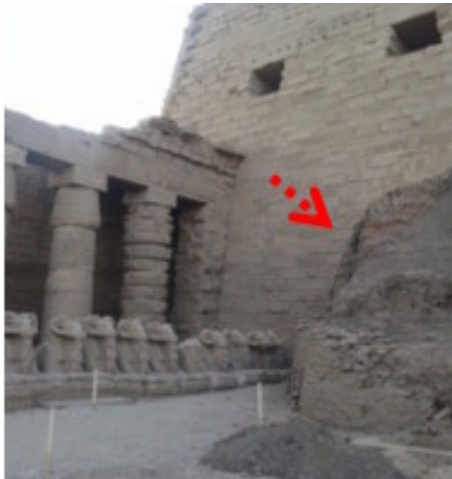
شكل رقم ٨- استخدام قوالب من الطوب اللبن وكسر الفخار كمنحدرات لبناء الصرح الأمامي بمعبد الكرنك، الأقصر، الباحث
