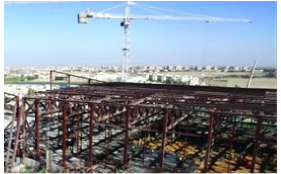
شكل رقم ١٣- استخدام القطاعات المعدنية في إنشاء مول مصر بالسادس من أكتوبر، الباحث.
