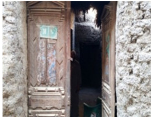
شكل رقم ٥- بيت ريفي تقليدي مبني بالطوب اللبن، قرية شريف باشا، بني سويف، المصدر : الباحث
