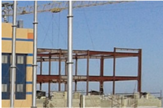
شكل رقم ٤١- استخدام القطاعات المعدنية في إنشاء توسع رأسى لمبنى مستشفى جامعة ٦ أكتوبر، الباحث.
