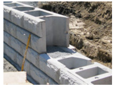
شكل رقم ١٥- نماذج مختلفة لاستخدام بلوكات الطوب المتداخلة والمفرغة في الحوائط الحاملة، شبكة الإنترنت.
