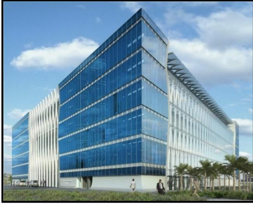
شكل (9) لقطه منظوريه لمبني دار الهندسه ،
