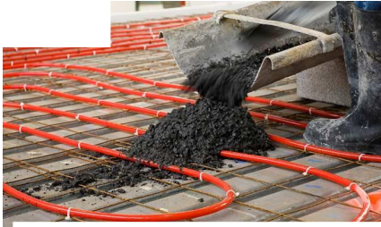
شكل ( 16 ) أنابيب المياه الحرارية لحظة صب أرضية المسكن
